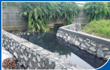
Pembuatan Drainase untuk Desa
